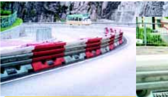
充水式防撞系統（筲箕灣耀興道）。 Water-filled barrier at Yiu Hing Road, Shaueiwan.
